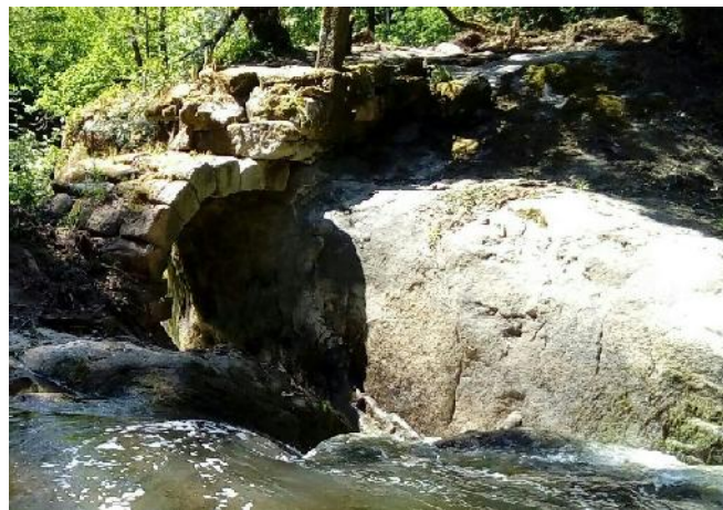
Acondicionamento Ponte Cabirta
